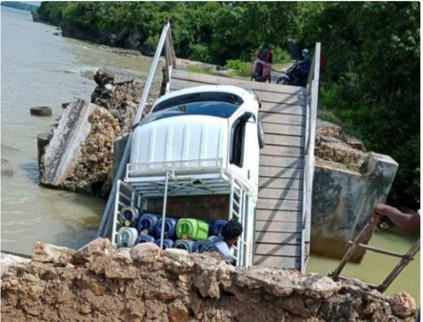
Mobil Pengangkut BBM Terguling Di Jembatan Desa Sonok // Foto : Kiki
